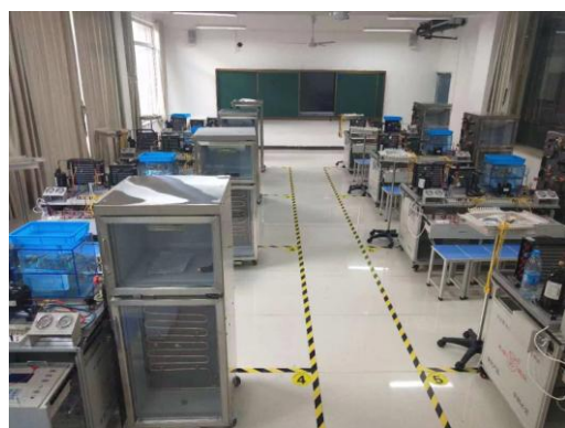
通风空调实训室
